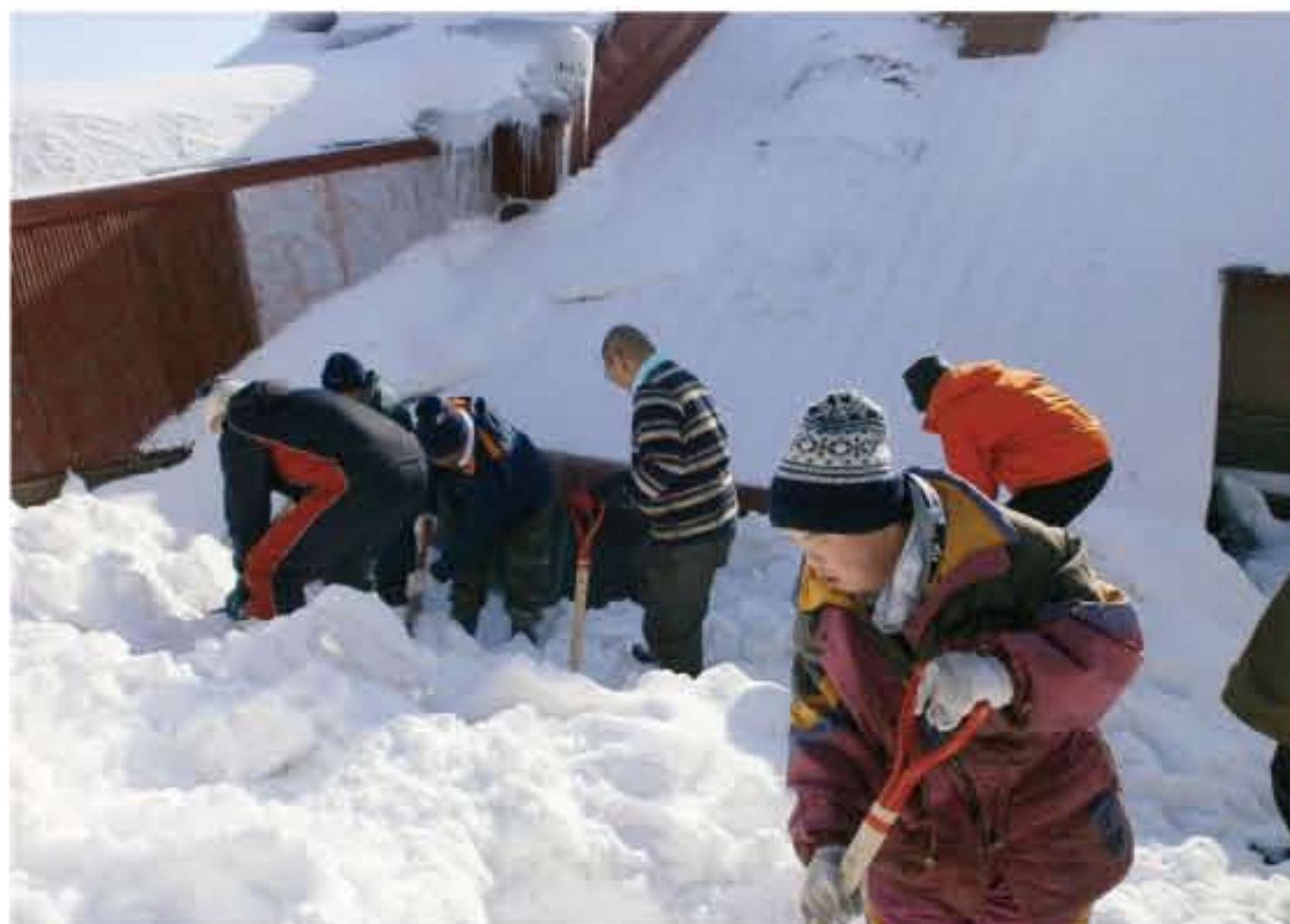
屋根からの落雪でふさがってしまった窓や玄関周りを除雪
