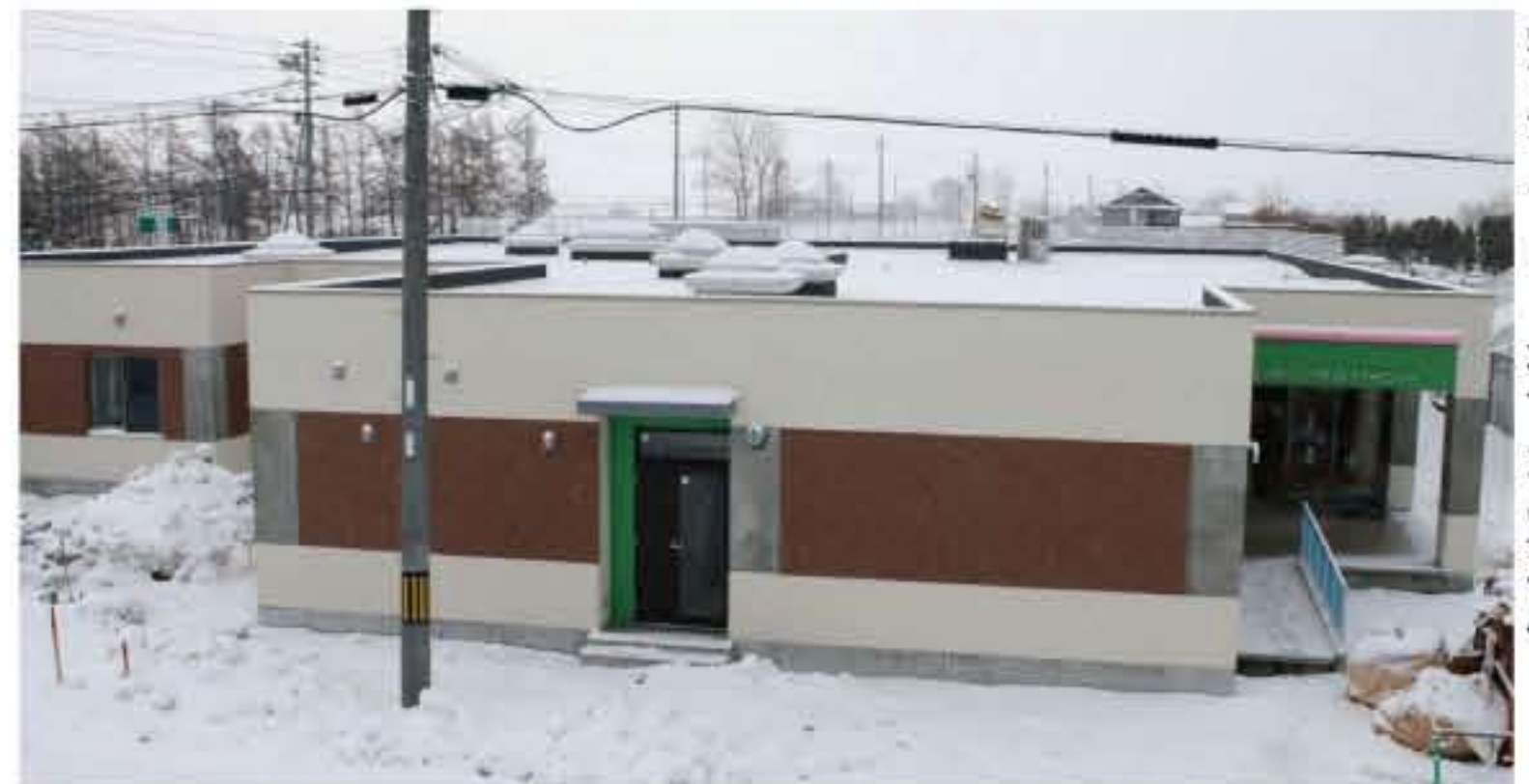
工事用の囲いも取り外され 完成まであとわずかの建屋
