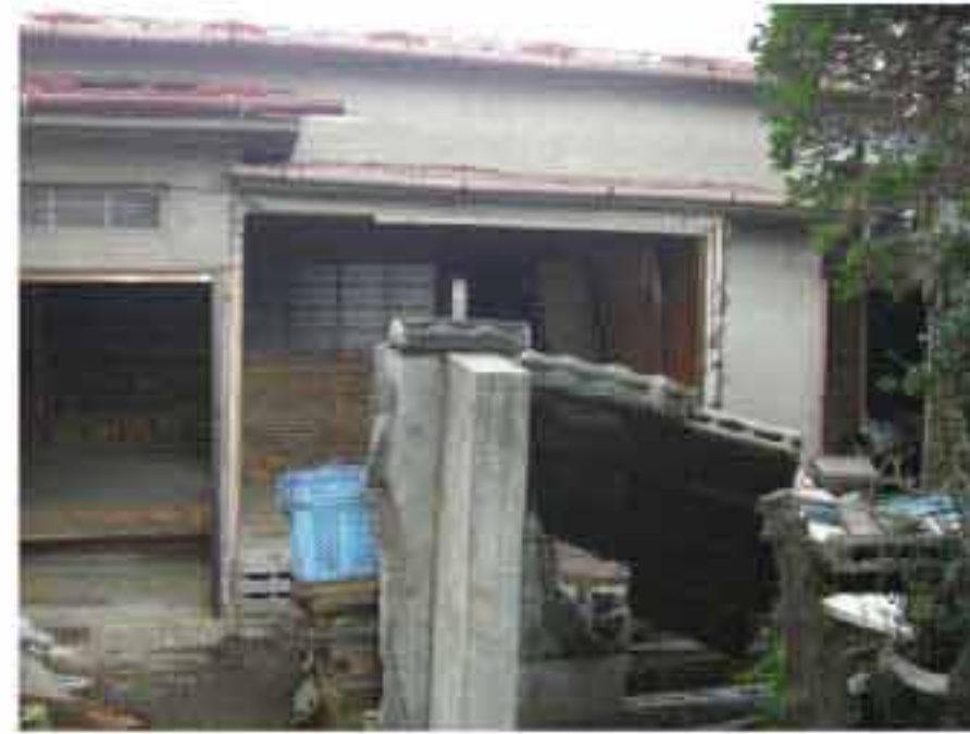
津波の被害を受けた石巻市魚町(写真・右)と市街地の建物
