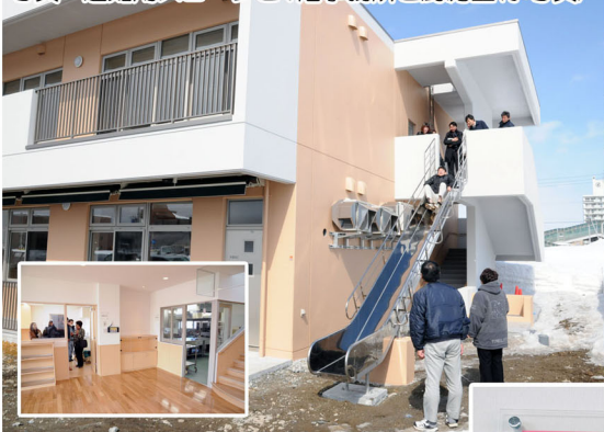
写真・避難用スロープと1階事務所と厨房室(小写真)
